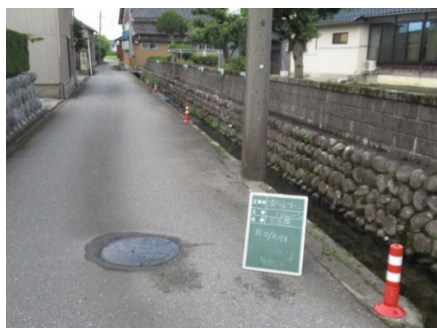
写真 1 O 集落における設置状況
