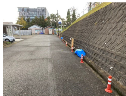
写真 2 パークゴルフ場横道路の設置状況
